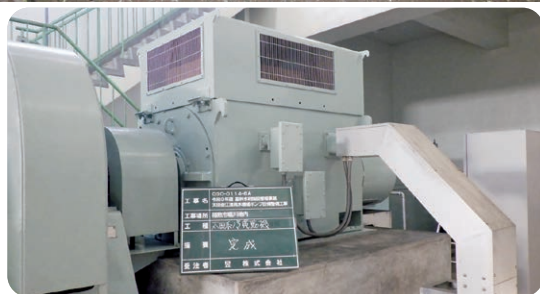
太田金江津用水機場ポンプ整備工事 太田系電動機整備 2台
