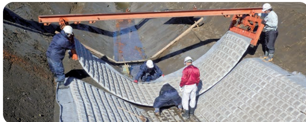
上) 金江津1号排水幹線水路護岸工事 中央) 四箇2号幹線排水路護岸工事 下) 八筋川用排水路護岸工事
