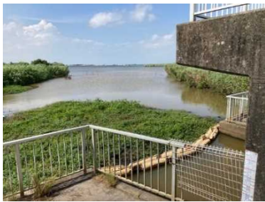
①侵入防止フェンス
