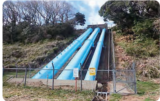
太田送水管塗装
