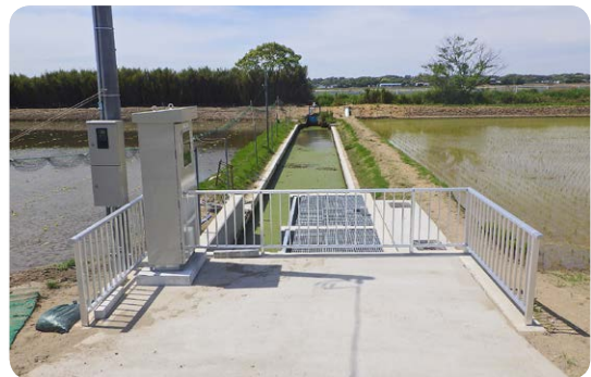
西の洲第2 機場
