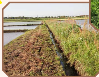
ゴミ撤去後の排水路
