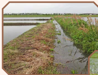
ゴミにより詰まった排水路
