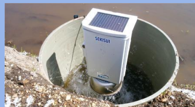
自動給水栓による給水の様子 (S社製品)
